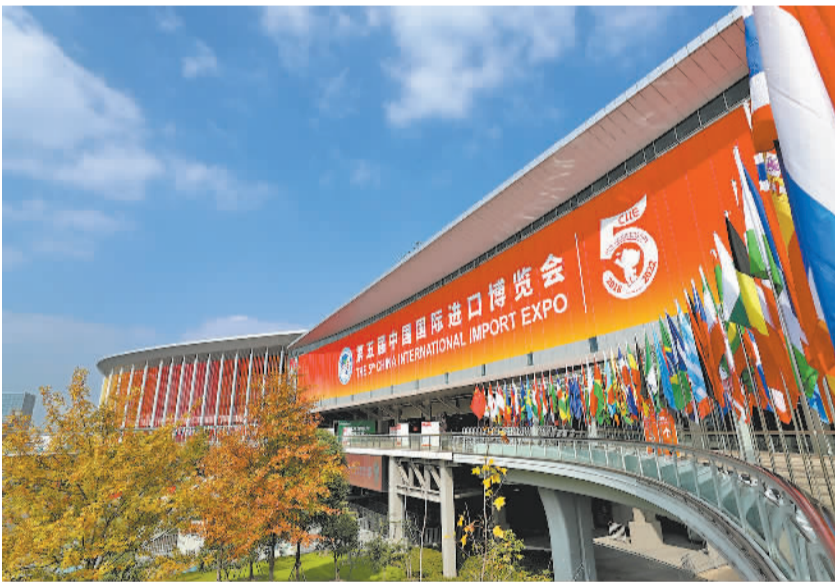
11月2日拍摄的国家会展中心(上海)西入口。当日,第五届中国国际进口博览会各主要展馆布展工作进入收尾阶段,展品陆续进场安置到位,国家会展中心(上海)从内到外装饰一新,迎接进博会开幕。新华社记者 方 喆摄
