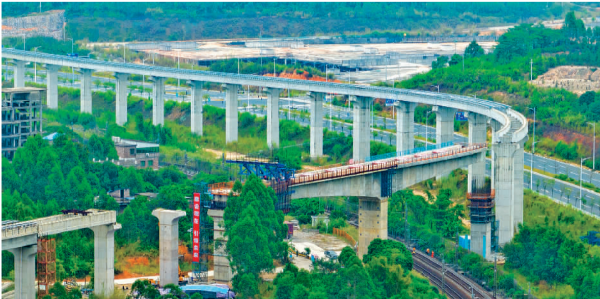
11月8日，广东清远磁浮旅游专线长隆特大桥跨京广铁路连续梁成功转体，标志着该项目主体工程全线贯通，为联调联试奠定了基础。项目建成后，将对助力清远加速融入“轨道上的大湾区”具有积极意义。金伟摄(中经视觉)
