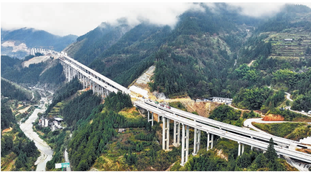
11月14日，在贵州省黔东南苗族侗族自治州榕江县塔石瑶族水族乡，雷(雷山县)榕(榕江县)高速公路项目正在加快建设。该高速公路开通后，将实现沪昆高速与厦蓉高速的最短连接，对完善贵州省高速公路网、构建区域综合交通运输体系、打造黔东南精品旅游快速通道具有重要意义。
