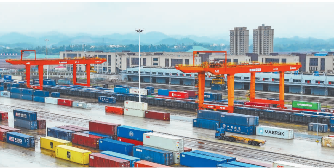
11月17日，在江西省赣州国际陆港货场，龙门吊起重机正在吊运集装箱货柜，货车装卸作业来来往往，现场一派繁忙景象。
