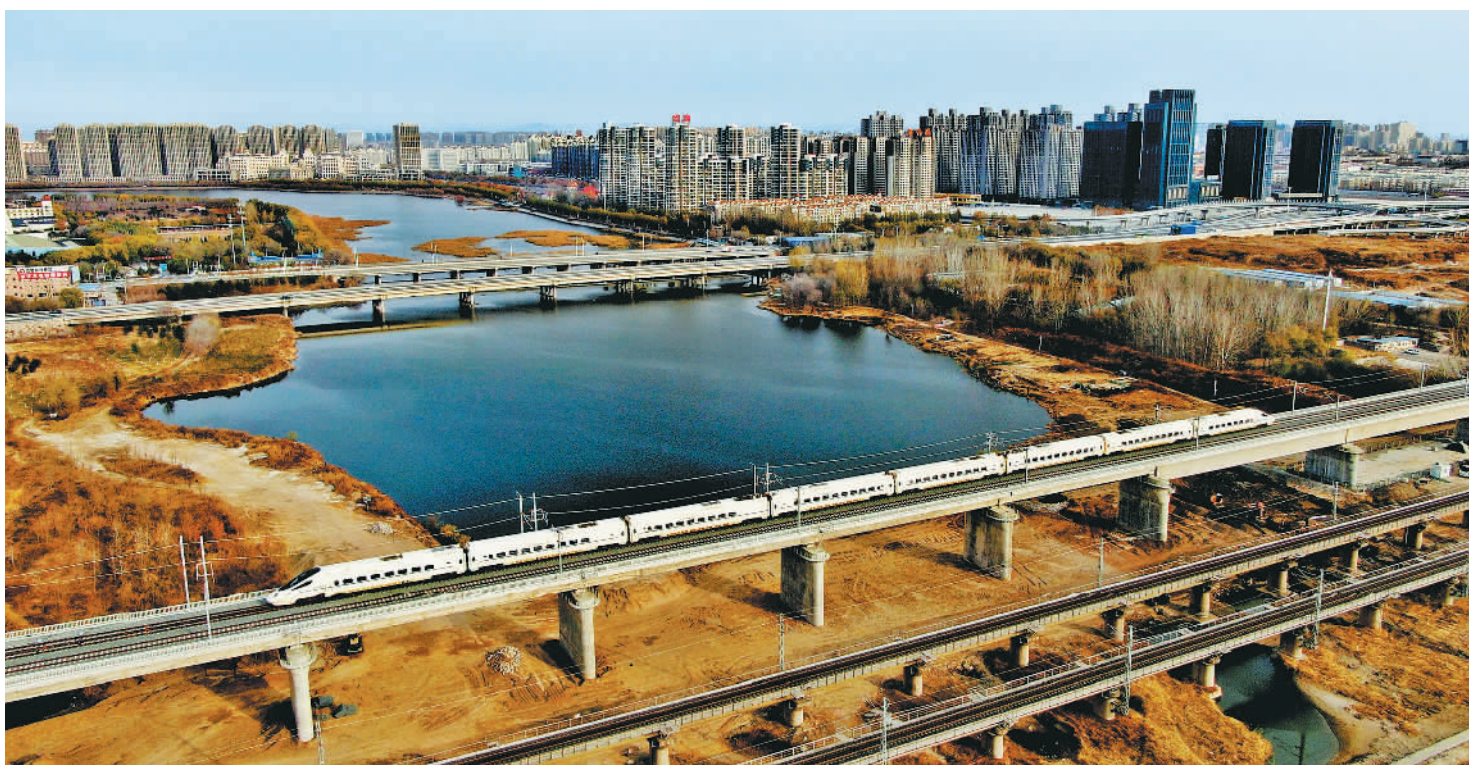
11月26日,D6601次试验列车驶过京津冀的潮白河大桥。当日,京唐、京滨(北段)城际铁路正式接入北京站,北京站至河北唐山站、北京站至天津北辰站进入全线运行试验阶段。两条城际铁路建成通车后,将进一步完善京津冀地区铁路网结构,便利沿线人民群众出行。
