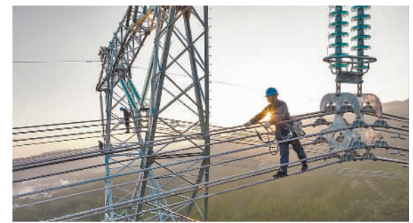
3名高空作业人员依次对三相导线进行核查验收
