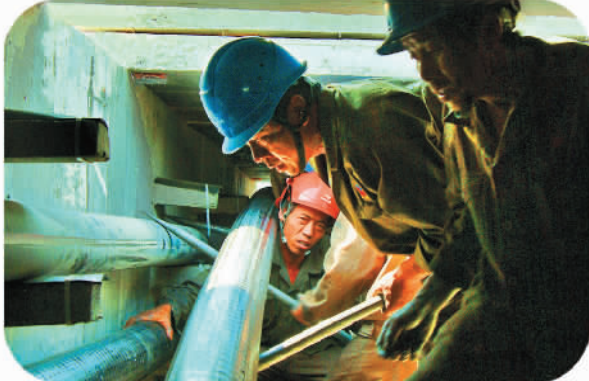
2008年4月,南方电网广东珠海供电局对粤澳联网220千伏第一通道进行施工。图为施工人员在敷设电缆
