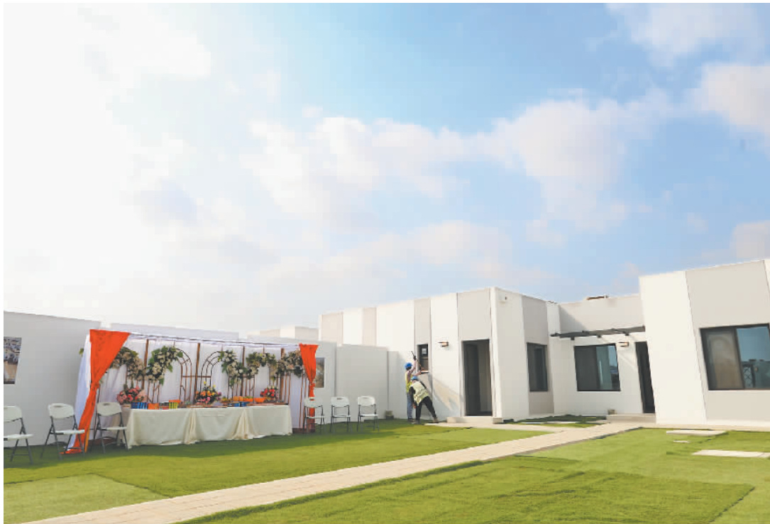
图为中国电建承建的沙特保障房吉赞项目。
