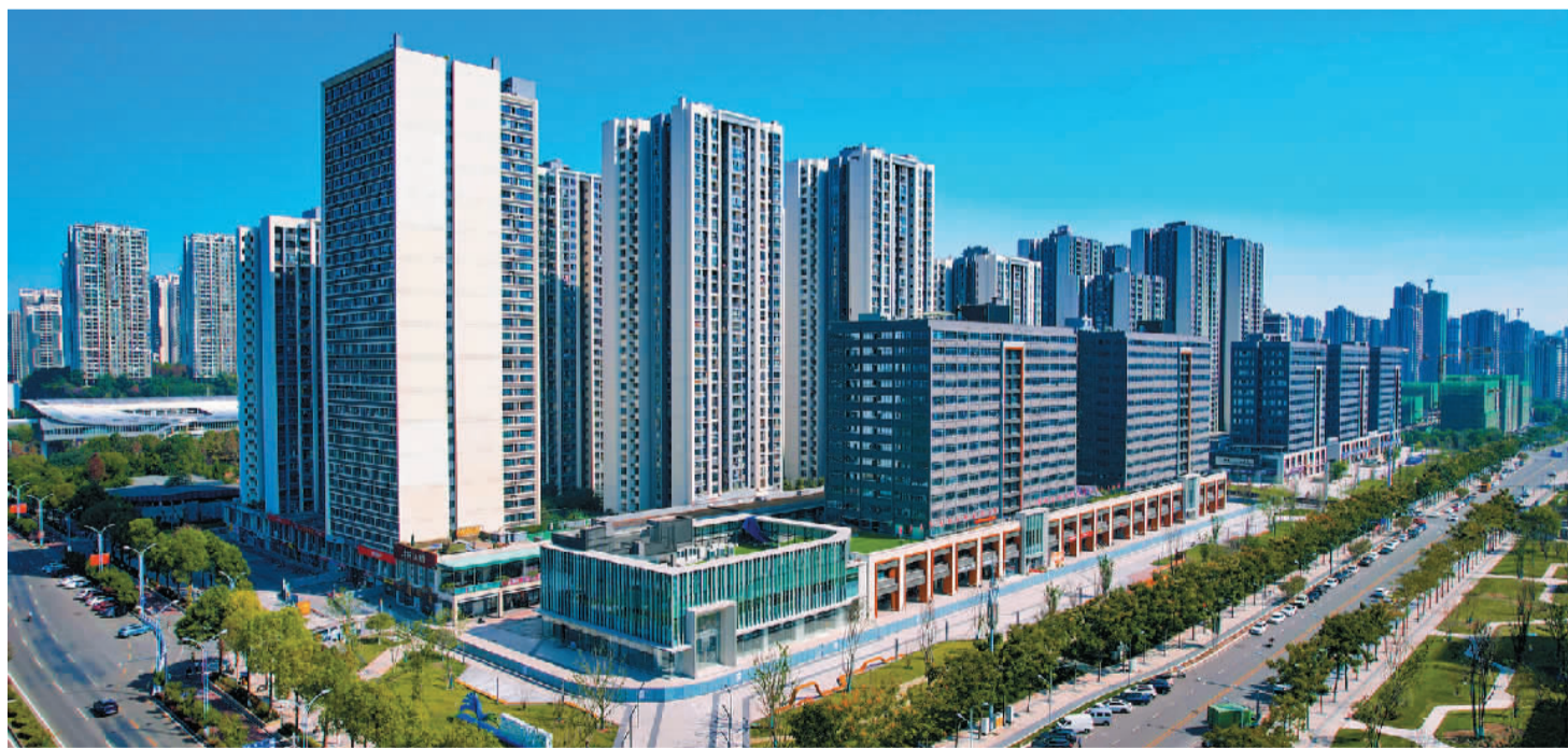
金凤软件园(虎溪园)一期
