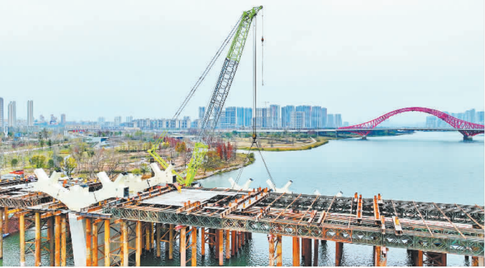
1月3日,江西省赣州市赣江新区的赣州平安大桥建设项目工地,工人正在吊装钢梁。据悉,该桥建成后将连通赣江新区与章江新区,有力促进区域互联互通。朱海鹏摄(中经视觉)
