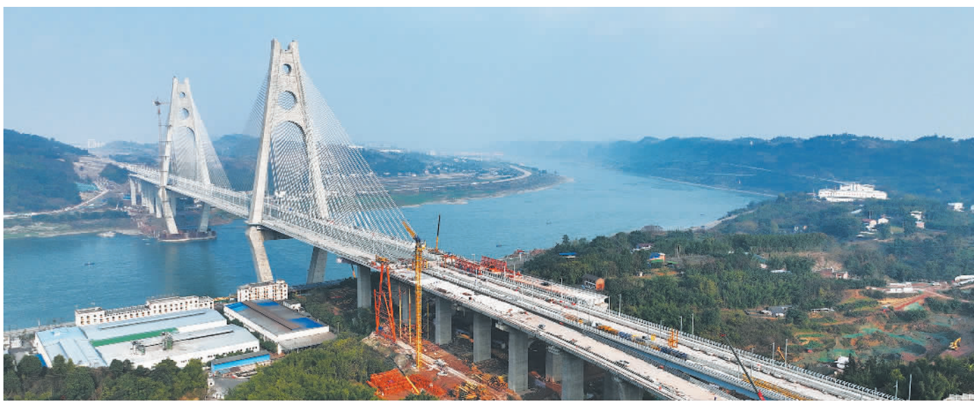
1月5日航拍的新建川南城际铁路自贡至宜宾线宜宾临港公铁两用长江大桥。随着大桥最后一方混凝土浇筑,大桥主体施工顺利完成。宜宾临港公铁两用长江大桥全长1742.1米,桥面宽63.9米,建成后将成为世界最宽的公铁两用桥,有力推动川南城市群融入成渝地区双城经济圈建设。
