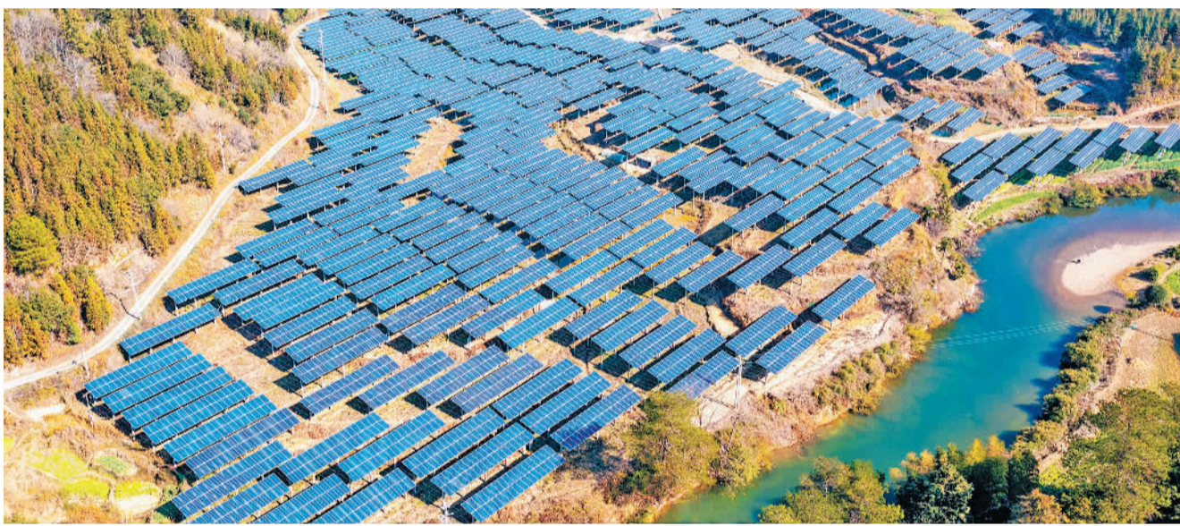
1月7日,湖南省通道侗族自治县马坝光伏电站,光伏板正源源不断地输送清洁能源。近年来,当地积极打造绿色能源基地,大力发展风电、光伏发电、水电等清洁能源,引导企业走绿色发展道路。李尚引摄(中经视觉)
