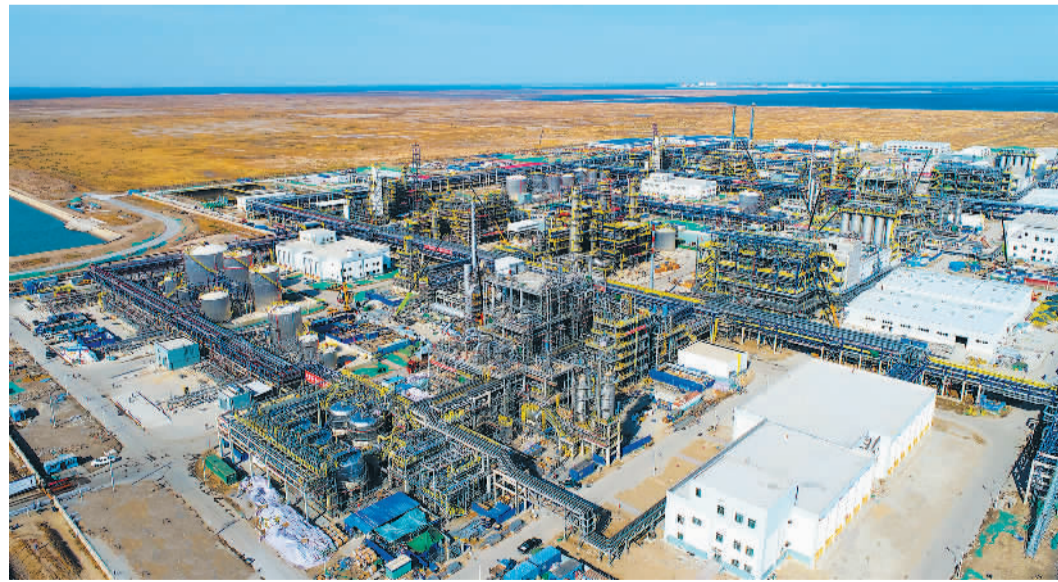
图为中沙(天津)石化有限公司项目施工现场。
