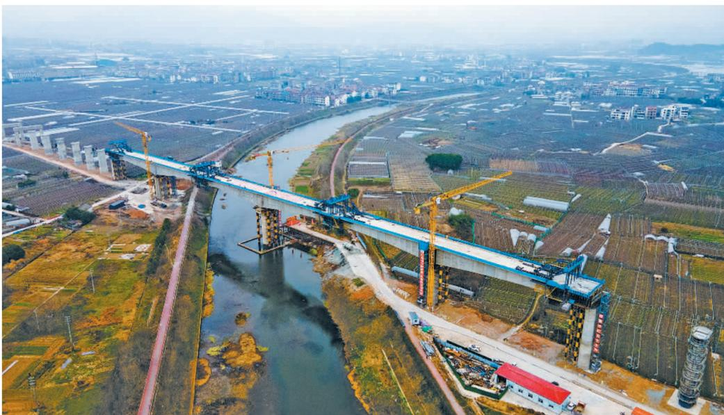
1月10日,位于浙江省金华市浦江县、由中铁十二局承建的杭温铁路二期项目最大跨度连续梁——浦江特大桥390米连续梁顺利合龙。杭温铁路二期项目总投资94.8亿元,工程从桐庐东站引出,经桐庐、浦江、义乌三县(市),接沪昆高铁义乌站,计划于2024年6月通车。项目建成后,将串联起杭州、金义都市经济圈,是浙江加快实现全省“1小时交通圈”的关键节点工程。胡肖飞摄(中经视觉)
