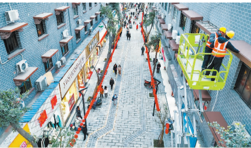
1月18日,四川省眉山市小北街特色商业街西区改造项目正在进行收尾工作。该项目紧邻全国重点文物保护单位——三苏祠,将绿色可持续、历史文化传承、共建共治共享理念融入规划建设管理全过程,进一步提升城市内涵品质,改善居民居住条件,促进文化旅游融合发展。
