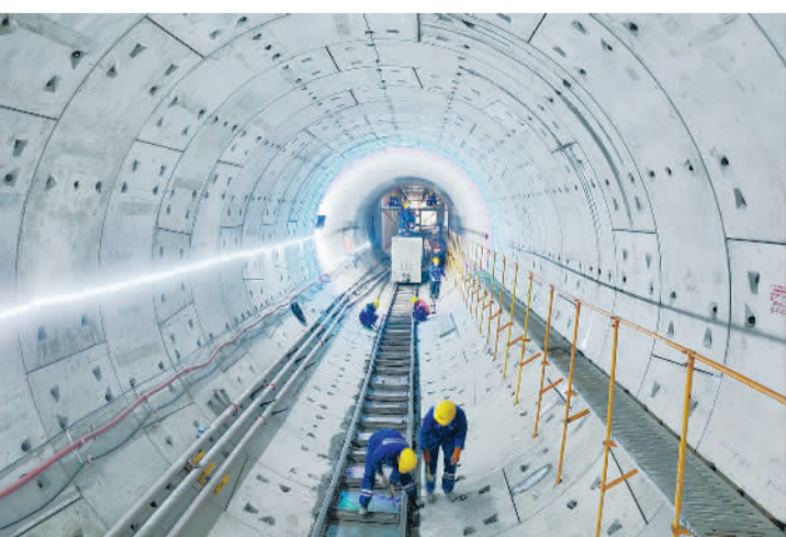
1月26日，浙江省湖州市德清县杭德市域铁路建设现场，中铁隧道局的建设者在进行轨道养护作业。该项目春节期间不停工，建设工人坚守在施工一线，全力抢抓工期进度。杭德市域铁路工程全长25.6公里，通车后将满足沿线群众多元化出行需求。 谢国高摄（中经视觉）
