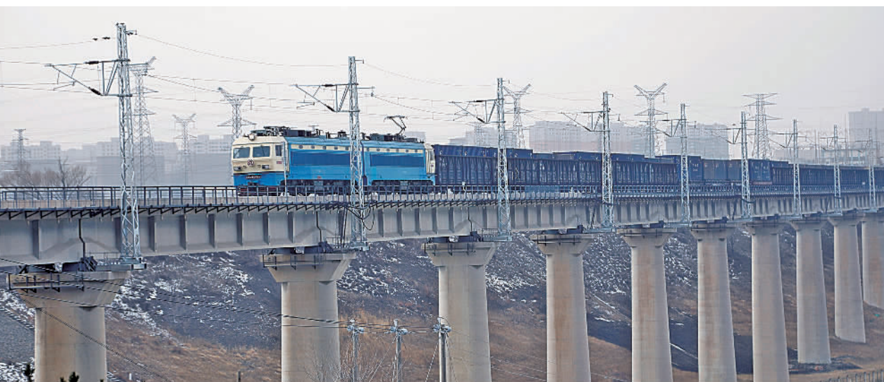
2月27日,内蒙古集宁至通辽的首趟铁路电气化货物列车行驶在轨道上,标志着“蒙煤东运”大通道集集铁路正式跨入电气化时代。孙江摄(中经视觉)
