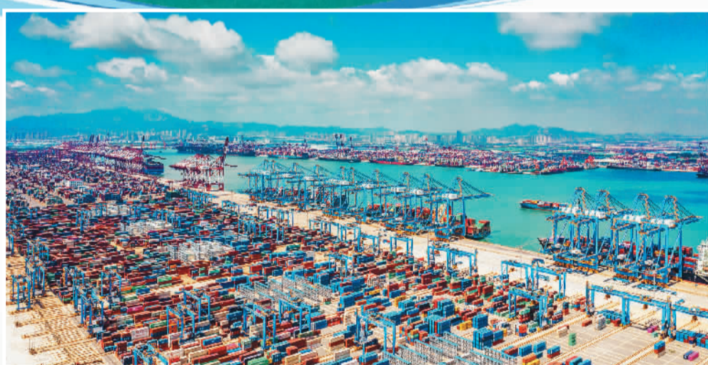
山东港口青岛港码头
