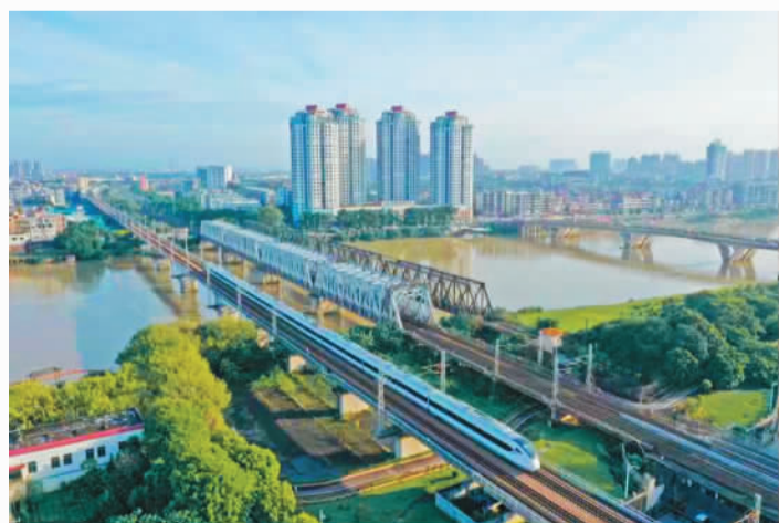
广深线动车组行驶在粤港澳大湾区东莞市石龙大桥
