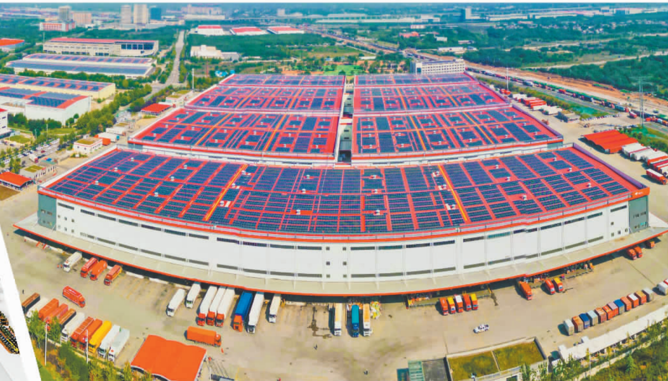
京东率先在国内建成“零碳”物流园区,京东“亚洲一号”西安智能物流园区
