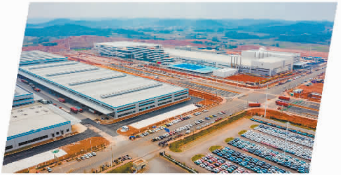
位于青秀区伶俐镇的伶俐工业园区建设热火朝天
