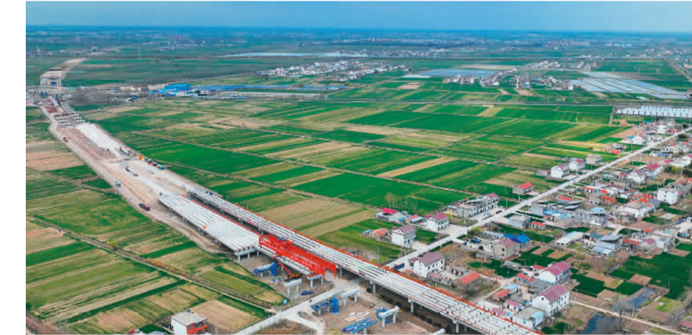
3月16日,连宿高速公路连云港段灌云东枢纽互通式立体交叉主线桥加紧施工。连(云港)宿(迁)高速公路建成通车后,将进一步完善区域高速公路网络,促进沿线经济发展。
