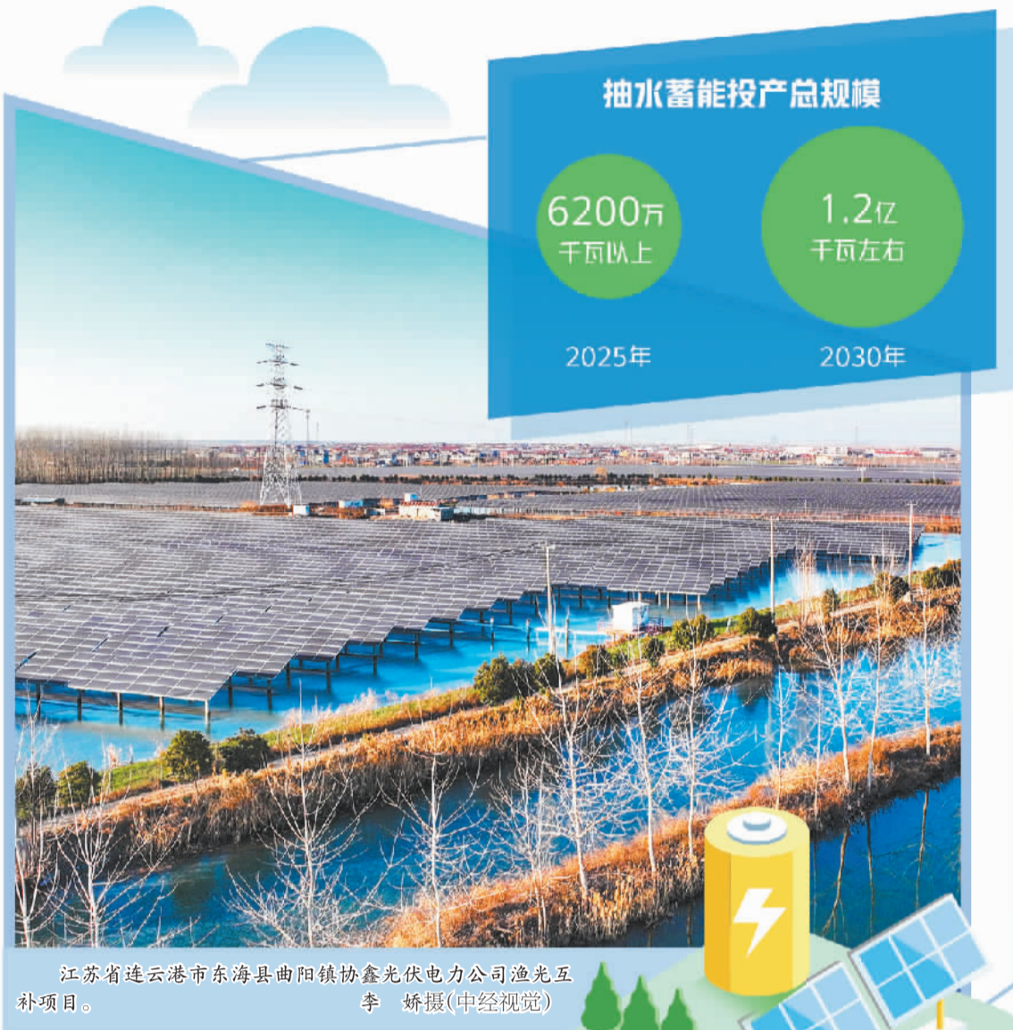
江苏省连云港市东海县曲阳镇协鑫光伏电力公司渔光互补项目。
