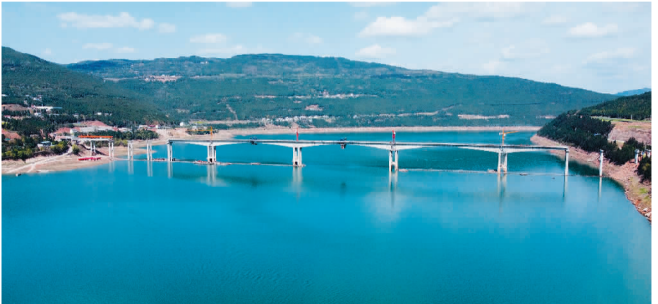
3月26日,由中铁十五局承建的四川省广元市南流嘉陵江大桥主桥顺利合龙,预计8月份具备通车条件。大桥通车后,将从根本上解决亭子湖库区周边群众的出行难问题,促进当地经济社会发展。(杨智博摄/中经视觉)
