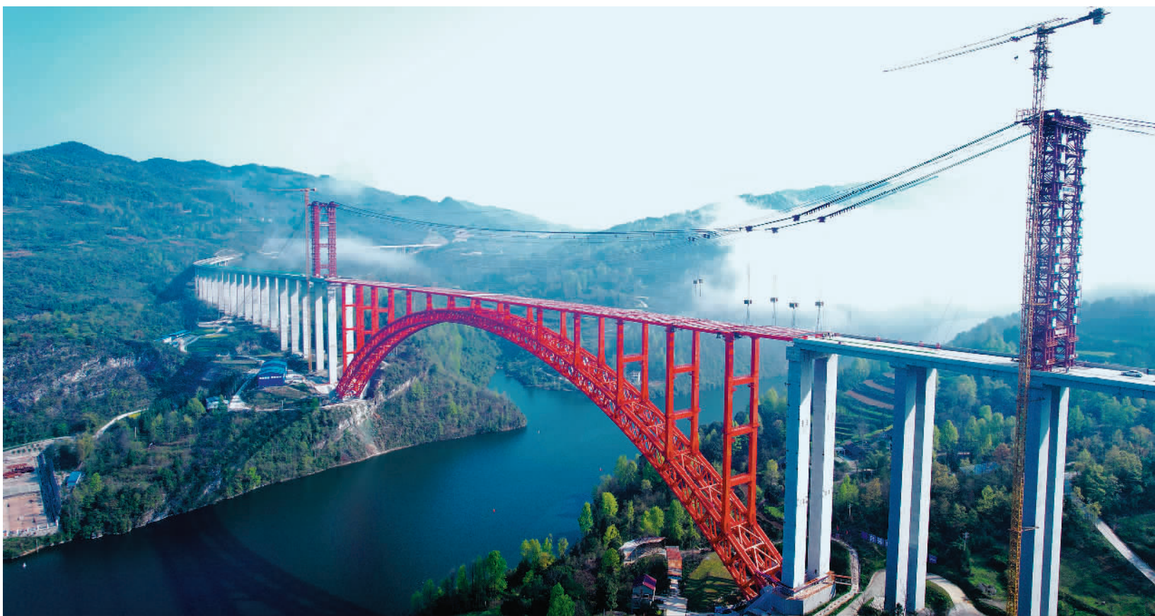
3月30日拍摄的贵州德余高速乌江特大桥。当日,随着一节重达180余吨的桥面板精准就位,德(江)余(庆)高速公路乌江特大桥钢结构施工全面完成,大桥主体贯通。 大桥位于遵义市凤冈县、铜仁市思南县和石阡县的交界处,全长1834米,主跨504米,是目前世界最大跨径的上承式钢管混凝土拱桥。 刘叶林摄(中经视觉)
