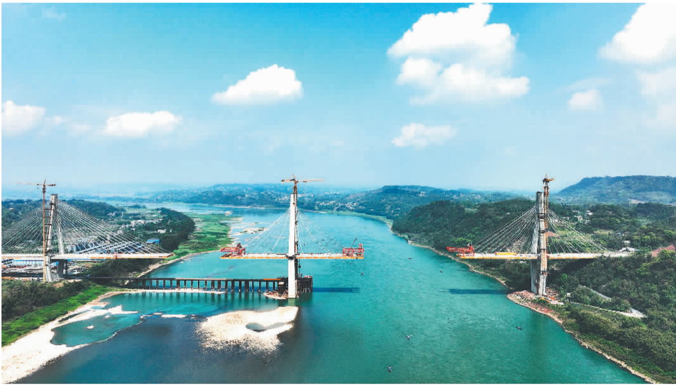
3月29日,在位于长江四川省宜宾市江安县段的江安长江二桥项目现场,建设者正在安装桥面钢梁。大桥预计于5月底合龙。该桥建成后,将极大提升江安县城交通运输水平,缓解区域内长江两岸交通压力,提升区域内路网快捷通畅能力。兰锋摄(中经视觉)
