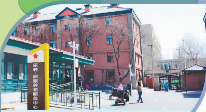
包头市自由路2号街坊里的养老服务中心。
