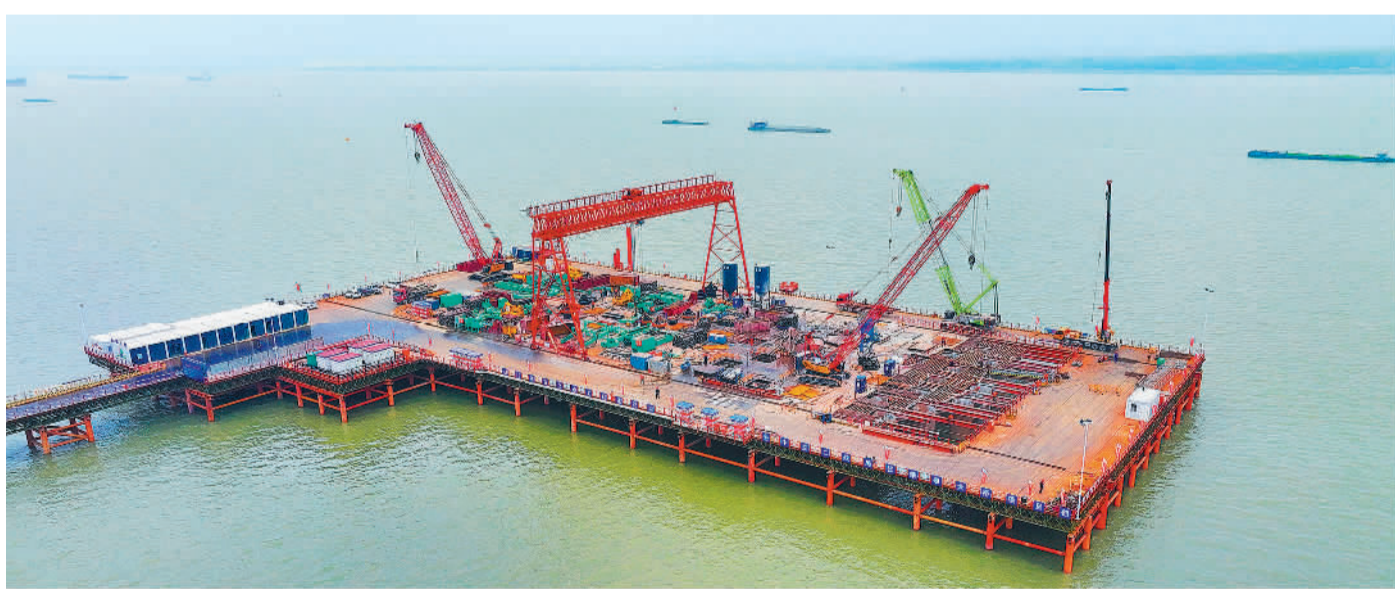
4月15日，由中交二航局参建的江苏张靖皋长江大桥关键控制性工程——南航道桥南主塔桩基施工完成。
