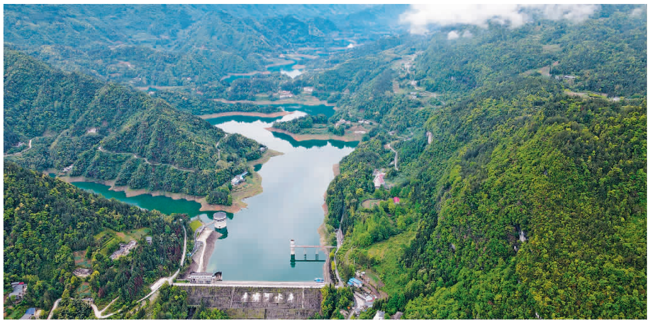
5月11日,位于湖北省恩施土家族苗族自治州恩施市屯堡乡的车坝水库,青山绿水相互掩映。湖北省级重点民生工程——车坝河引水工程近日完工通水,正式向恩施市第二、第三水厂送水,为百姓提供优质供水保障。 谢 顺摄(中经视觉)
