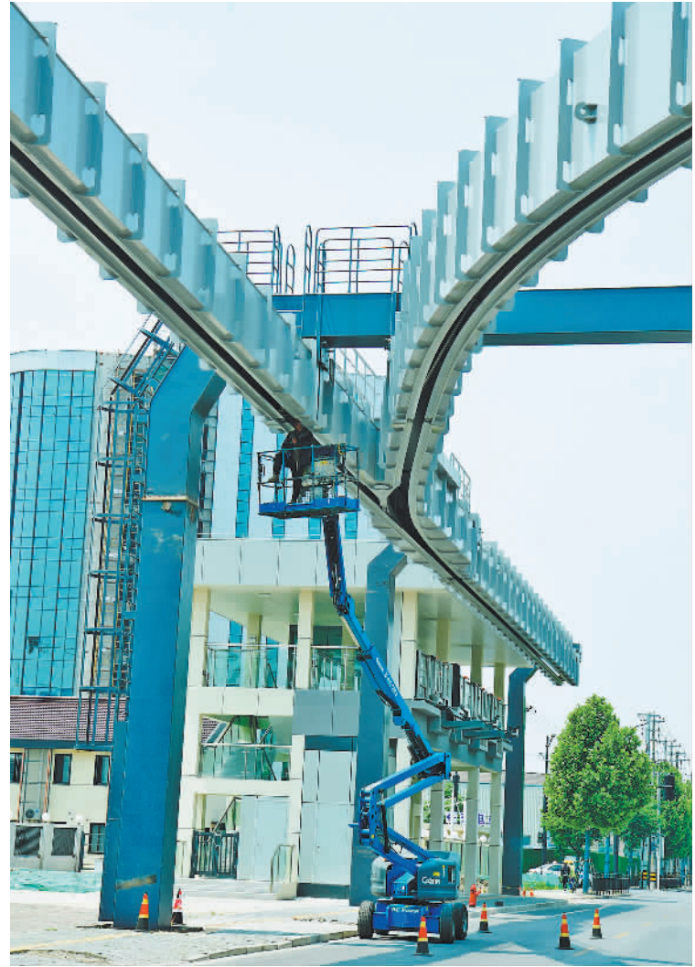
5月13日,上海首条空轨轨旁空铁示范线项目现场,施工人员正对空中轨道进行安装调试。该示范线项目首期400米轨道及车站已经建成,有望今年下半年试运行。 计海新摄(中经视觉)
