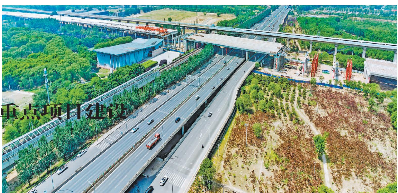
5月15日,在不封路、不断流情况下,由中国中铁六局施工的京雄高速公路(北京段)上跨京良路、地铁房山线钢梁顶推就位。自此工程进入最后冲刺阶段,为年内全线贯通奠定了坚实基础。
