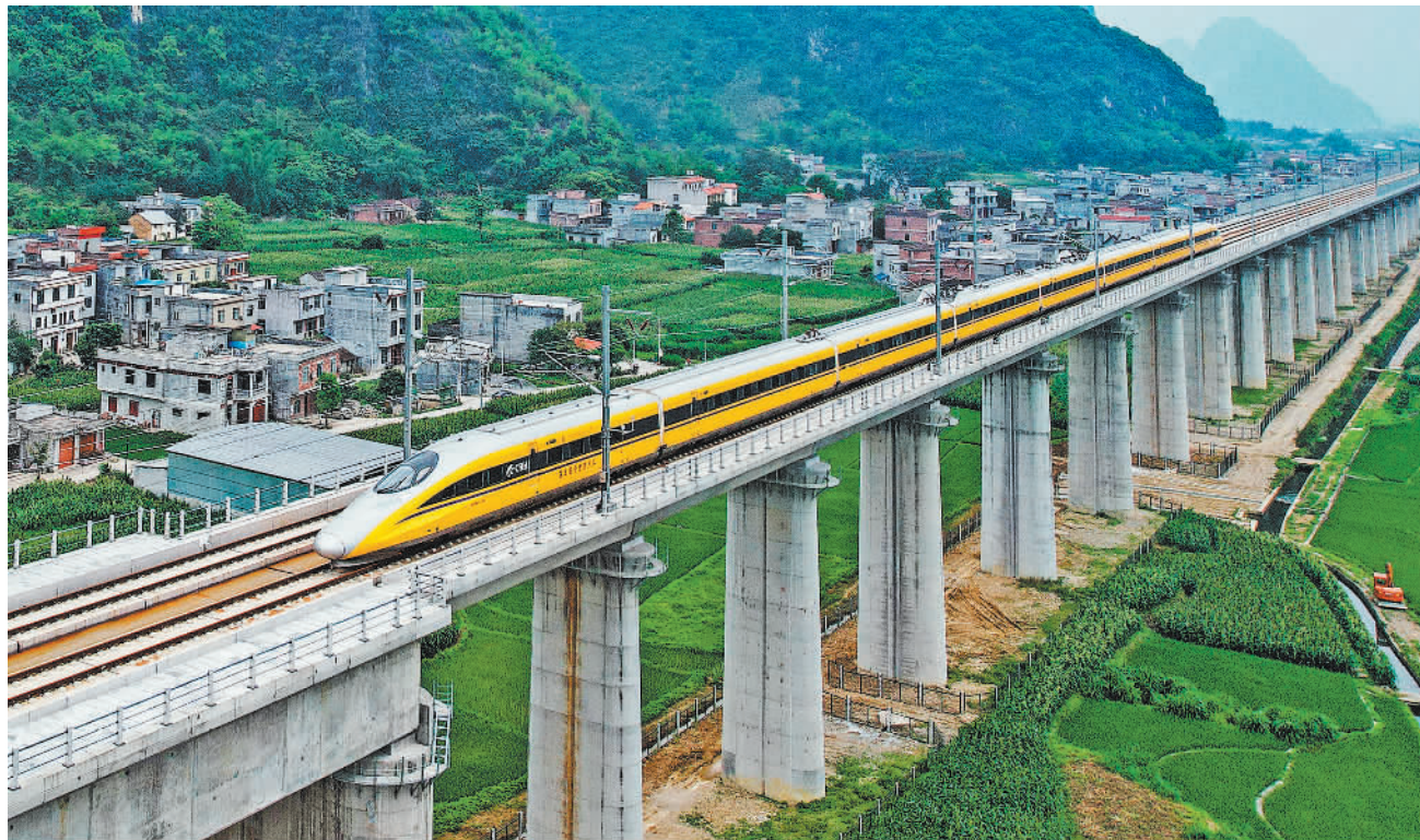
5月16日,高速综合检测列车行驶在贵南高铁上进行检测工作。当日,CRH380AJ-0203高速综合检测列车对贵南高铁全线进行逐级提速试验,以时速180公里的速度级,对南宁东至荔波站区间高铁沿线的轨道、信号、通信、电务、综合接地等多个项目进行检测。
