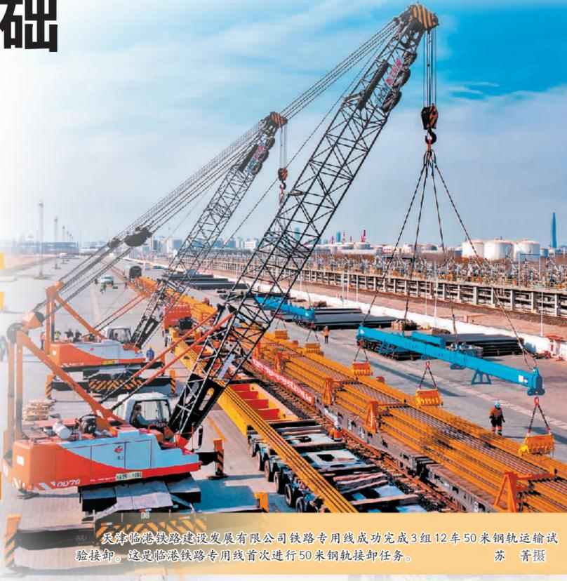
天津临港铁路建设发展有限公司铁路专用线成功完成3组12车50米钢轨运输试验接卸。这是临港铁路专用线首次进行50米钢轨接卸任务。 苏 菁摄
