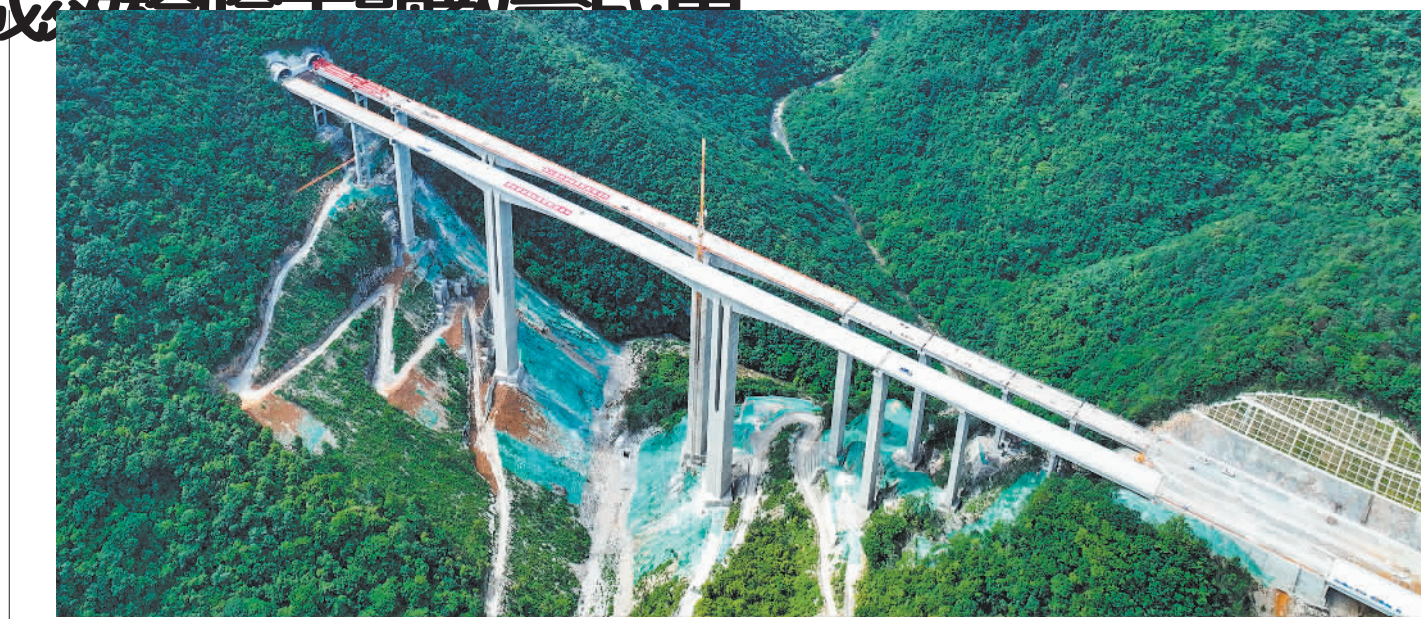
6月9日,由中铁一局一公司承建的贵州省遵义市桐梓县至新蒲新区高速公路重点控制性工程——芭蕉湾特大桥左右幅全部贯通,为高速公路通车奠定了坚实基础。该高速建成通车后,将进一步提高区域交通通行能力和服务水平,对促进当地经济高质量发展具有重要意义。图为9日拍摄的芭蕉湾特大桥。本报记者 吴秉泽摄
