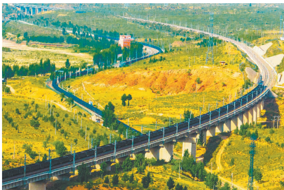
近日,满载电煤的列车行驶在包西(包头至西安)铁路包西至鄂尔多斯市黄河大桥上。入夏以来,为确保煤炭运输顺利“迎峰度夏”,中国铁路呼和浩特局及时掌握各电厂电煤消耗情况和运输需求,为电煤运输提供充足的铁路运力保障。夏亮摄(中经视觉)
