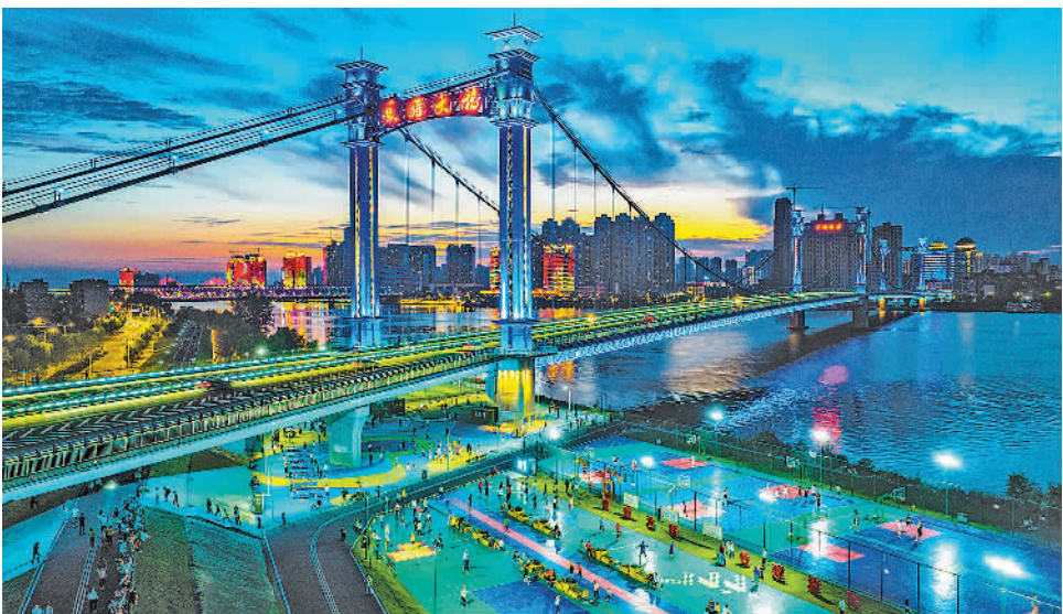
6月6日,在湖北省襄阳市凤雏大桥下的运动场地里,市民在参加多种体育活动。近年来,湖北省襄阳市在居民聚居区周边陆续新建、改扩建了多处休闲运动场所,以满足市民各种健身需求,构建更高水平的全民健身公共服务体系。 杨东摄(中经视觉)
