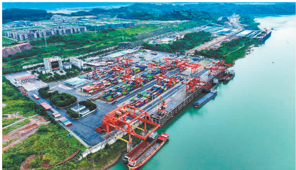
日前，四川宜宾港码头，水清岸绿，一派繁忙景象。近年来，为保护长江流域生态环境，宜宾港加大岸上电源布局，船舶靠港期间，用港口岸电代替传统柴油发电，满足船员生活、工作等需求，实现了“零油耗、零排放、零噪声”。 庄歌尔摄(中经视觉)
