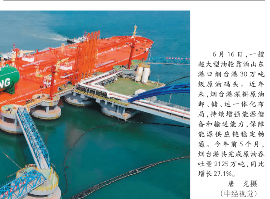
6月16日，一艘超大型油轮靠泊山东港口烟台港30万吨级原油码头。近年来，烟台港深耕原油卸、储、运一体化布局，持续增强能源储备和输送能力，保障能源供应链稳定畅通。今年前5个月，烟台港共完成原油吞吐量2125万吨，同比增长27.1%。
