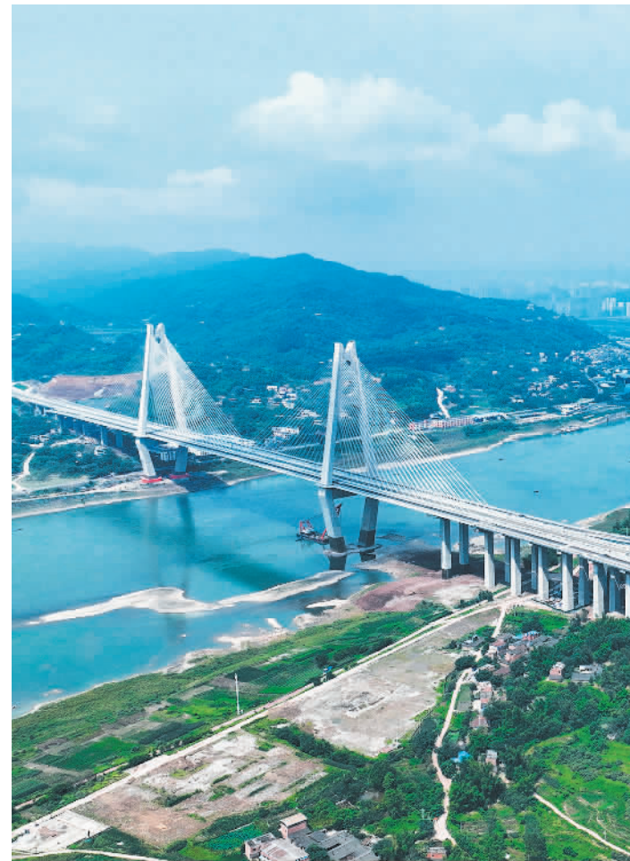
6月23日,正在加紧施工的四川省宜宾市宜宾临港长江大桥。该桥是世界首座公路和高速铁路同层合建桥,预计今年年底建成通车。 兰 锋摄(中经视觉)
