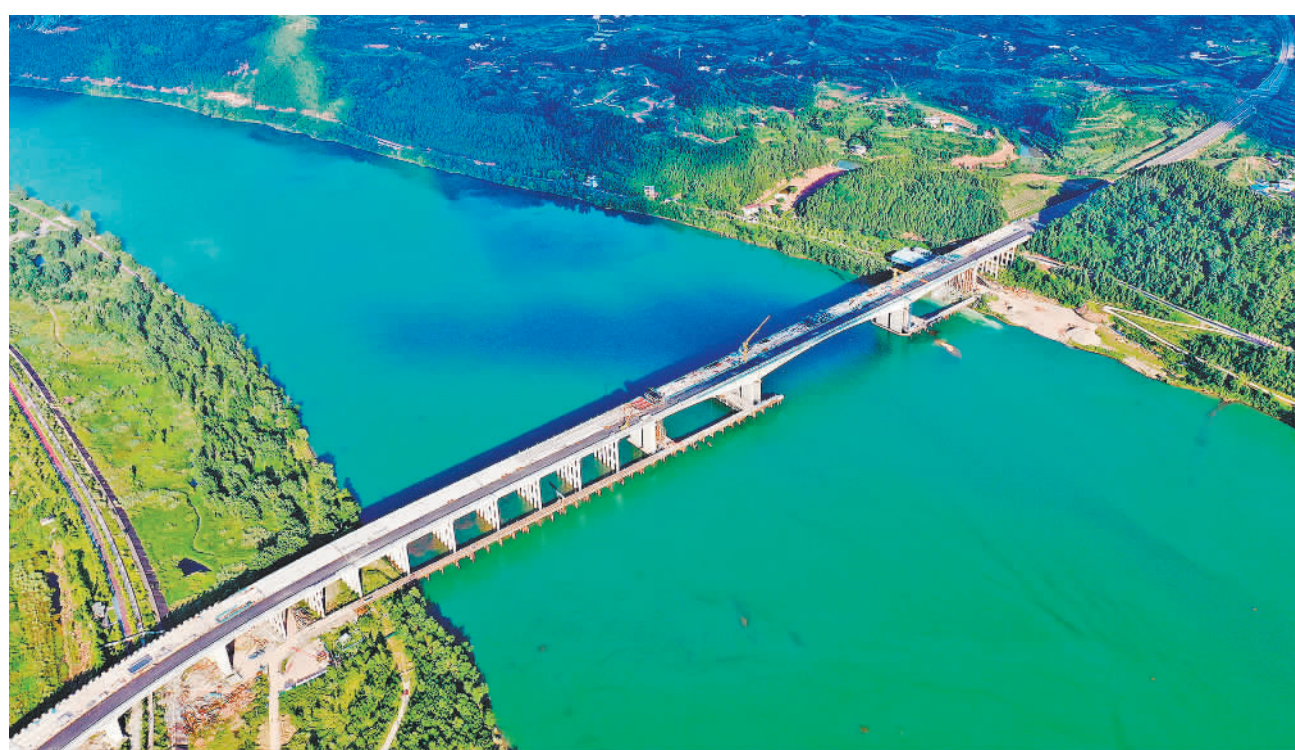
6月23日,四川省蓬安县嘉陵江三桥施工现场,工人们加紧施工保障工程进度。端午节假期期间,当地加速推进项目建设,多个重点项目施工不停歇,确保各项目如期完成。周亮摄(中经视觉)
