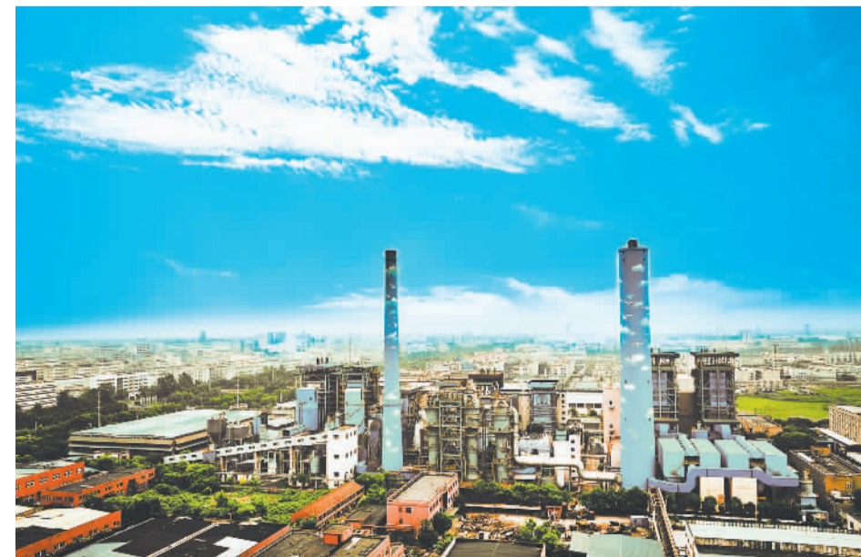
图为浙江春晖环保能源股份有限公司生物质热电联产扩建项目。该扩建项目日前投入运行,成为浙江省唯一一家利用垃圾、污泥、生物质三种资源进行焚烧热电联产的项目。
