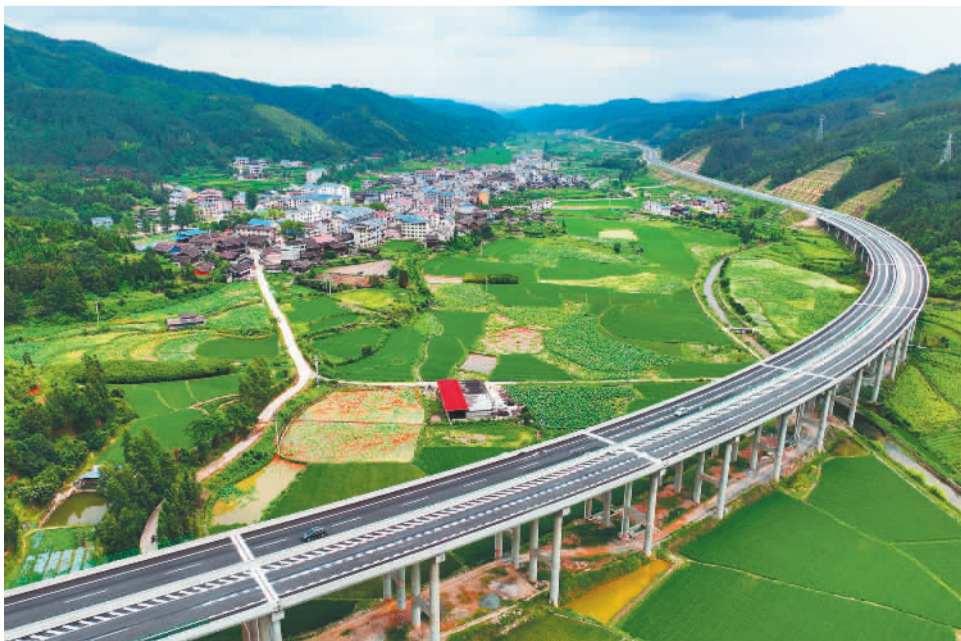
近日,湖南靖州—贵州黎平高速公路正式通车。靖黎高速公路主线全长56.98公里,采用双向四车道高速公路标准建设,行车速度100公里/小时,总投资56.49亿元。此高速为湘黔两省的一条新增通道,将极大改善沿线山区群众出行条件。 陈俊名摄(中经视觉)
