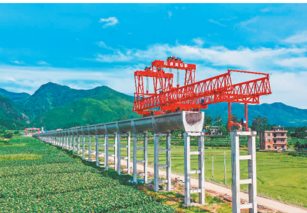
7月11日,湖南省永州市蓝山县毛俊水库灌区清溪渡槽工程施工现场,工人在有序施工。毛俊水库工程是全国172个重大水利项目之一,可灌溉农田41.15万亩。彭华摄(中经视觉)
