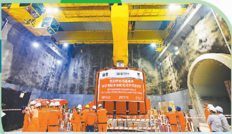
6月10日，工人在巴基斯坦开伯尔—普什图省的苏吉吉纳里水电站吊装最后一台机组转子。(新华社发)
