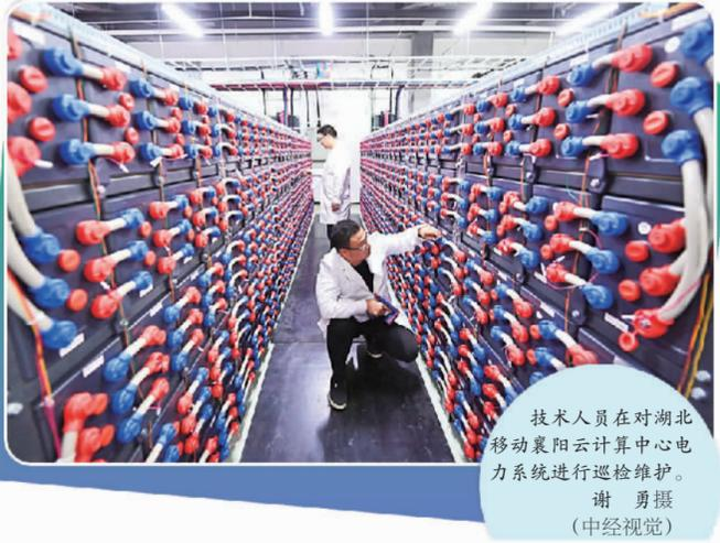
技术人员在对湖北移动襄阳云计算中心电力系统进行巡检维护。谢勇摄(中经视觉)
