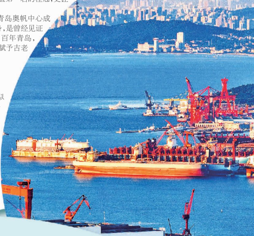
山东青岛西海岸新区海湾造船基地生机勃勃。韩加君摄(中经视觉)
