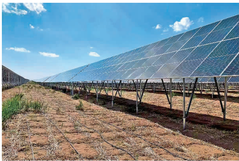
图为内蒙古巴彦淖尔磴口县20MWp光伏发电项目,通过“新能源建设+沙戈荒生态系统保护和修复”实现经济效益与生态效益相统一。(资料图片)
