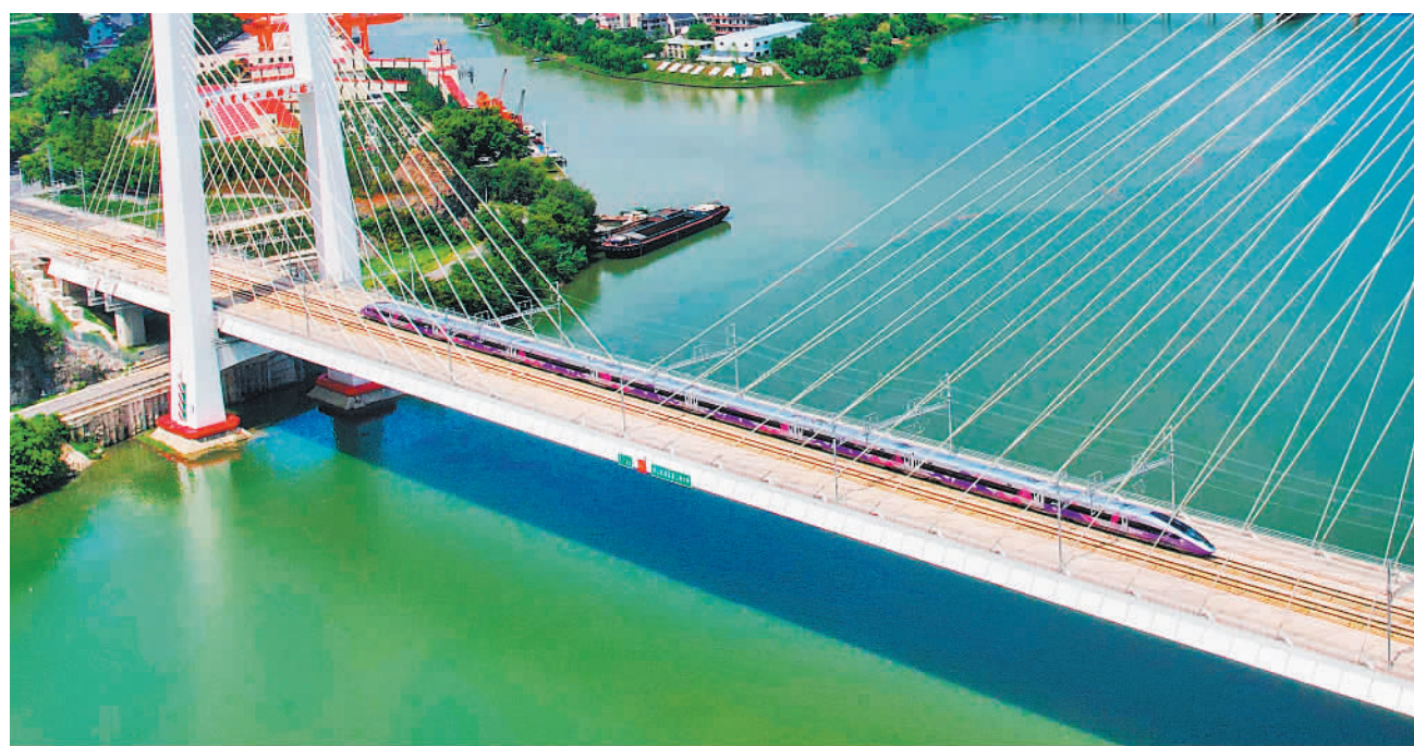
8月4日,浙江省杭州市复兴号亚运智能动车组列车驶过合杭高铁湖杭段富春江特大桥。当日是杭州第19届亚运会倒计时50天,专为杭州亚运会打造的复兴号亚运智能动车组列车迎来首次载客运行。周 国摄(中经视觉)
