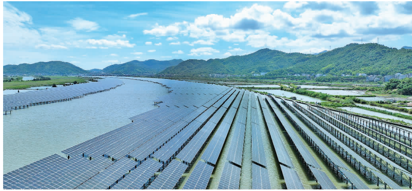
8月4日，浙江省温岭市坞根镇的龙源湖光互补智能光伏发电项目与蓝天白云交相辉映。近年来，温岭市坞根镇坚持党建引领，发挥生态和山海资源优势，打造100MWp湖光互补智能光伏发电项目，助力我国在海洋能源综合利用、新能源立体式开发建设等方面取得新成效。洪雨洁摄(中经视觉)
