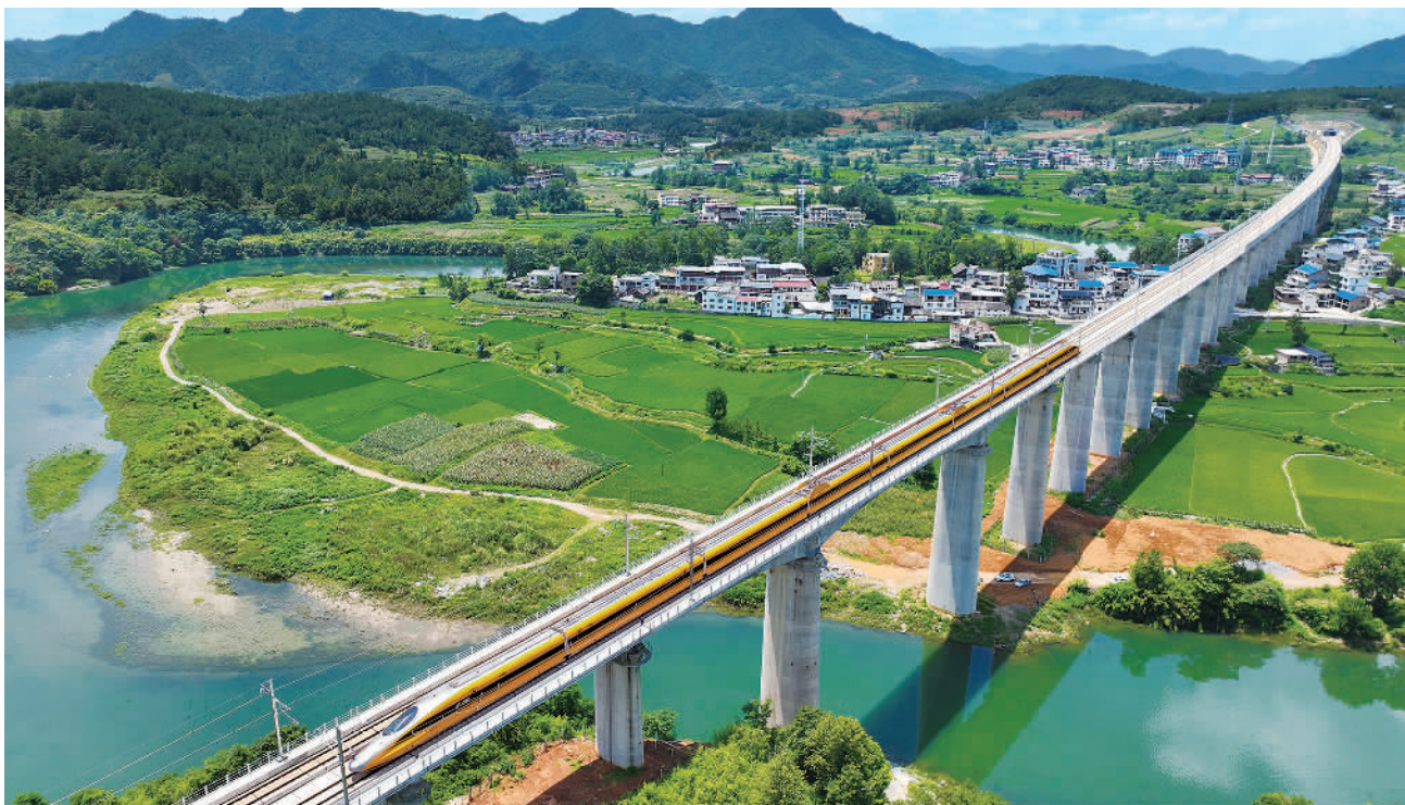
新建贵阳至南宁高速铁路贵阳至荔波段将于近日开通运营,贵阳至荔波最快57分钟可达。此次新开通的是龙里北站至荔波站,全线175公里。这是试验动车组经过位于贵州省都匀市的贵南高铁盘清水河双线特大桥。新华社记者 刘 续摄
