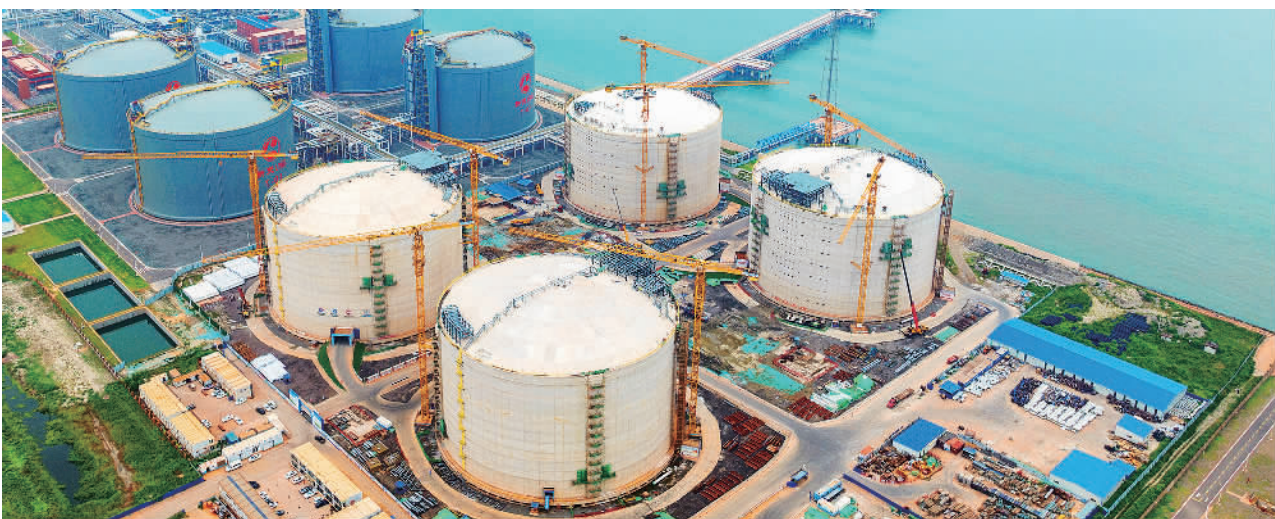
8月18日拍摄的河北省唐山市曹妃甸新天LNG项目施工现场。项目总投资253.9亿元,设计年接卸能力1200万吨,分3个阶段建设,预计2030年全部建成,将有力提高京津冀地区天然气应急调峰和供应保障能力。李春天摄(中经视觉)
